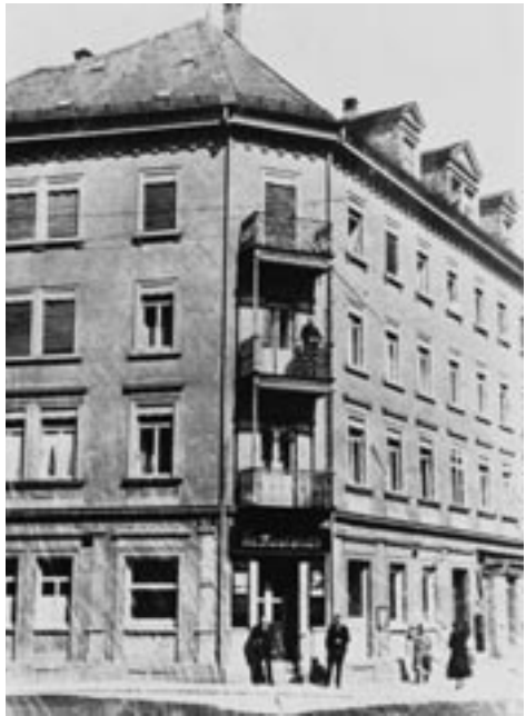
Das Geburtshaus in Ulm, Bahnhof- straße
